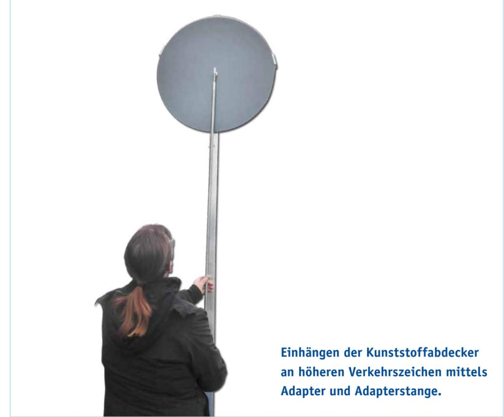
Einhängen der Kunststoffabdecker an höheren Verkehrszeichen mittels Adapter und Adapterstange.
