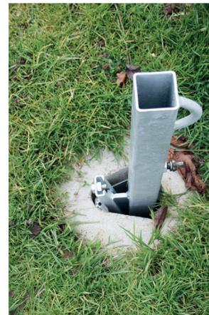
Die Halter für Leitpfostensockel passen in alle gängigen Leitpfostensockel, optimal sind die aus Beton. Da die Leitpfostensockel sehr unterschiedlich sind und je nach Bodenbeschaffenheit unterschiedlich gut halten, sind diese bezüglich der Standsicherheit wie z.B. ein Einschlagpfosten zu bewerten. Die Standsicherheit ist also von der Bodenbeschaffenheit abhängig. Daher ist der Aufsteller für den sicheren Stand des Verkehrszeichens verantwortlich.
